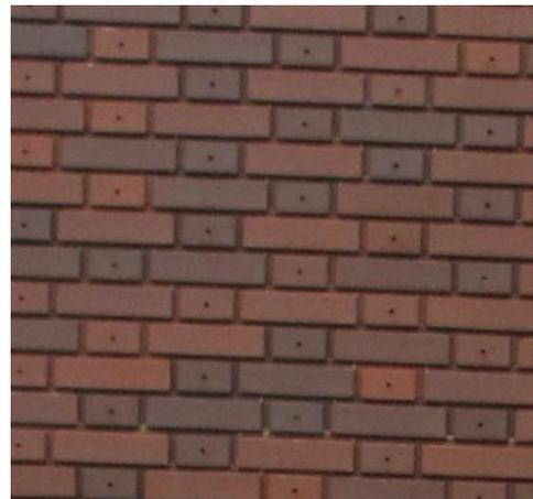
コンクリートを流し込みます。写真では見えにくいのですが、タイルの溝の部分に小さな穴が開いていて、それが桟木とパネルを留めていた釘穴です。レンガのように見えている個所に開いている大き目の穴は、セパレーターを留めていた穴です。
