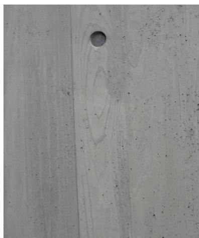
「my sky hole 85-2」の横を通って中央棟に向かって歩いていくと、中庭に降りる階段とエスカレーターがあります。階段横はコンクリートの壁になっていて、よく見ると表面に木目が見えます。コンクリートを流し込むために使用する型枠は以前には木で作られていて、型枠を外すとその木目がコンクリートに写っていました。この壁が作られた1975年頃はもう型枠のほとんどがプラスチック製となっていました。木目を出すためにわざわざ拘りの杉材を取り寄せて型枠として使用したそうです。
