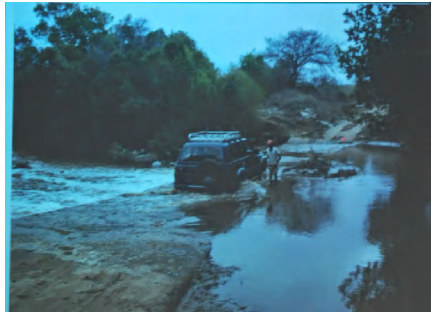
四万十川にあるような潜水橋（コンクリート製）
