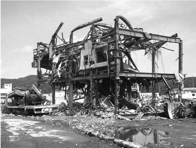
ねじ曲がった鉄骨建物
